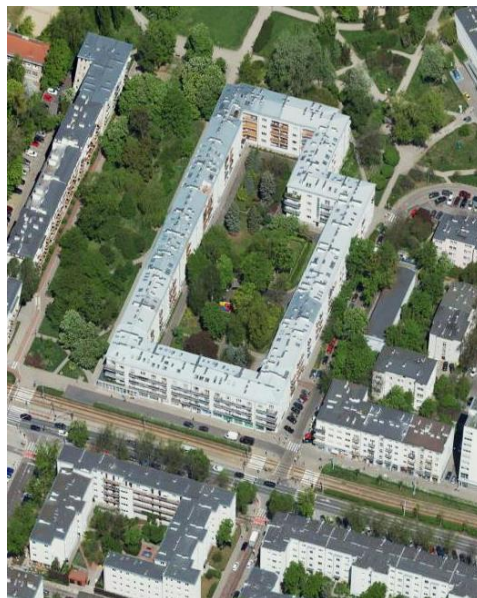
Zabudowa mieszkaniowa przy ulicy Augusta Cieszkowskiego
