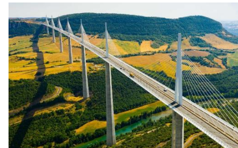
Wiadukt w Millau we Francji
